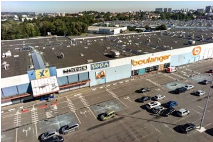
Parking du centre commercial –X% - secteur commercial
