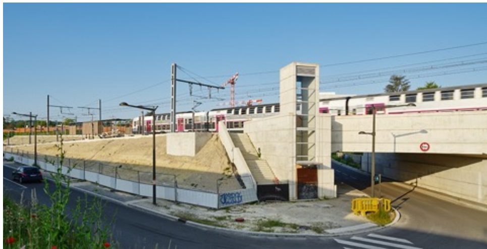
Accès de la future station tram-train T12
