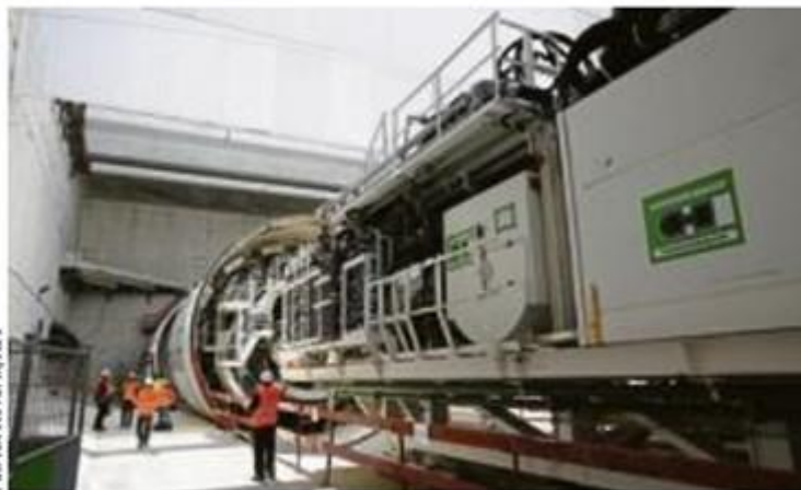
Ce prolongement sud de la ligne 14 bénéficiera à plus de 260.000 habitants de Paris, du Val-de-Marne et de l'Essonne.
